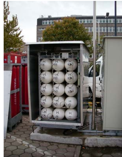
Abbildung 10: H 2 -Kompressor und H 2 -Pufferspeicher
