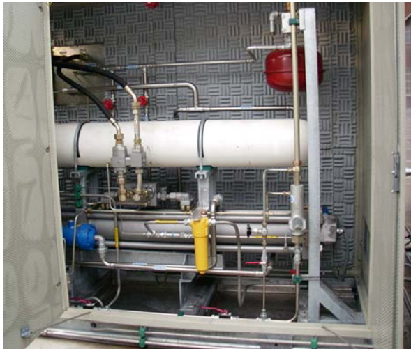
Abbildung 10: H 2 -Kompressor und H 2 -Pufferspeicher
