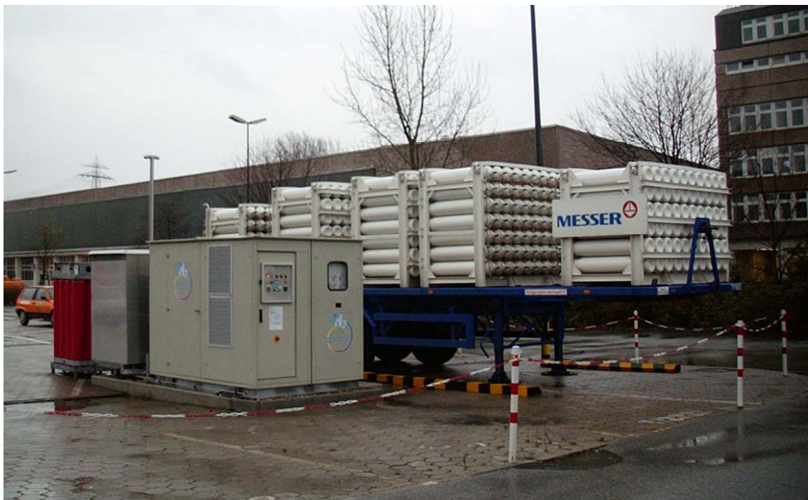
Abbildung 9: Wasserstoffversorgung mittels Trailer
